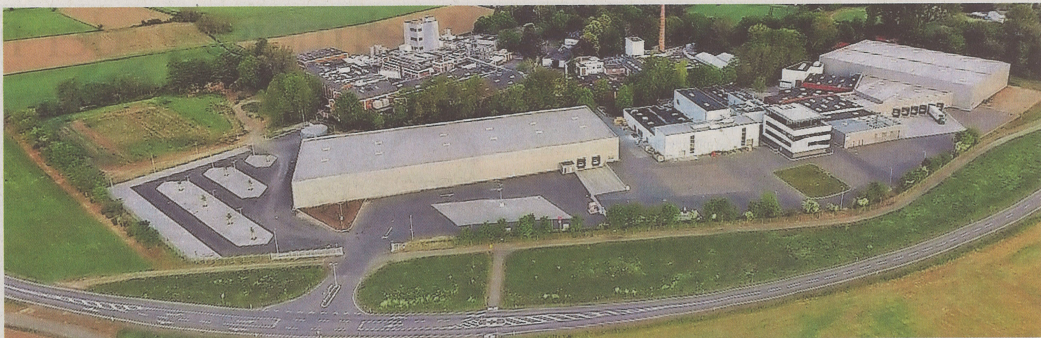
CWS-Fabrik in Düren-Merken aus der Luft: Der Hersteller von Pulverlacken geht in japanischen Besitz über.
