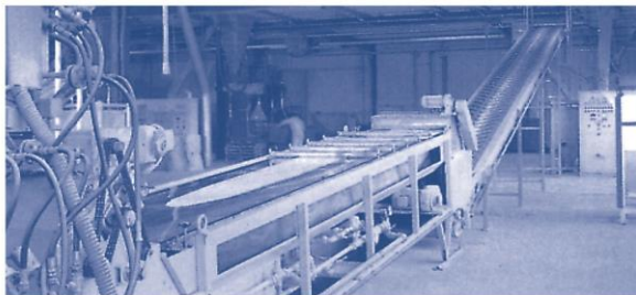
Extruderanlage mit Kühlband
